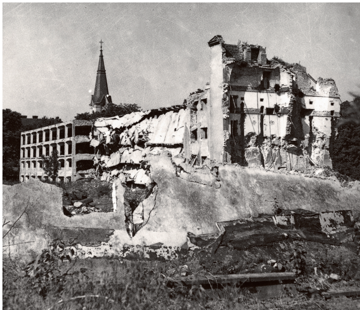
Demolice pivovaru, někdejší larischovské chlouby. V dubnu 1953 se propadlo nádvoří, následující den byl provoz zastaven a o měsíc později proběhl poslední výstav. V pozadí ční věž kostela sv. Jindřicha, který podlehl poddolování o několik let později. Fotografie ze sbírek Státního okresního archivu Karviná
