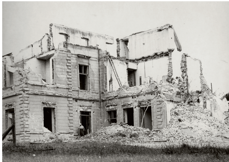
Demolice bývalého zámku a Domu zdraví v roce 1953. Fotografie ze sbírek Muzea Těšínska
