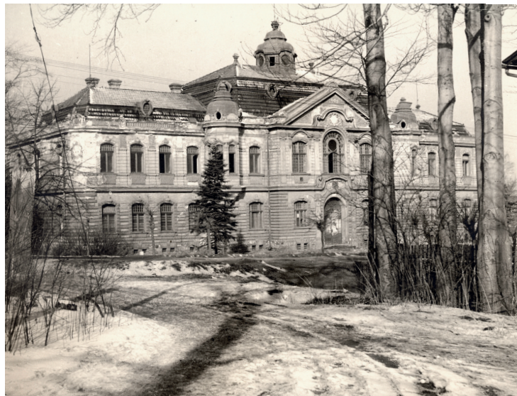
Karvinská radnice postavená v roce 1908 čeká na vykonání demoličního výměru jako poslední z výstavných budov centra Karviné (fotografie z roku 1962).
