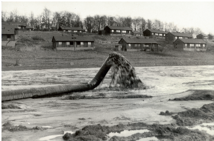
Proud kalové vody z Elektrárny IX. sjezdu KSČ zaplavující oblast pod nově vystavěnými dřevěnými, tzv. finskými domky neboli fiňoky, v karvinské části Solca.
